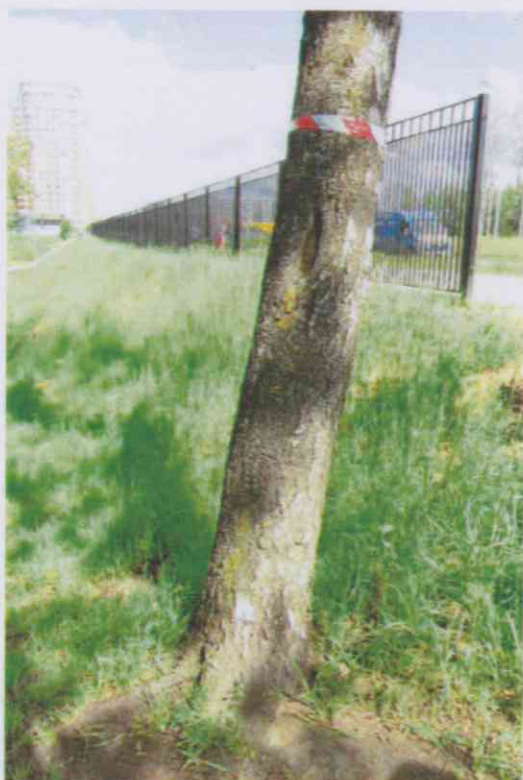
Фото 26 - Береза 5 - переуплотнение грунта в прикорневой части, механические повреждения ствола
